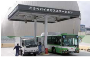
こうべバイオガスステーション 【神戸市】
