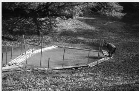
完成した足場
