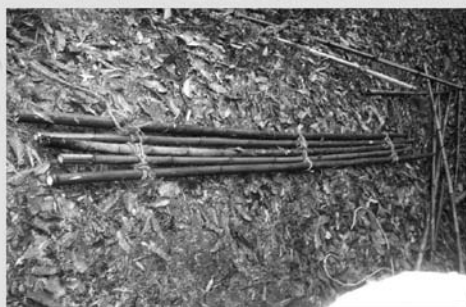
周りの竹を利用した足場の作成
