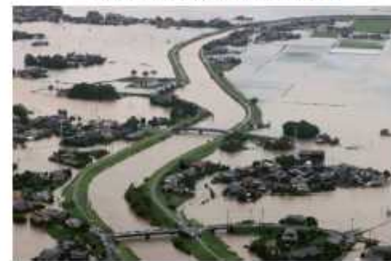
令和3年8月の大雨の被害の様子
